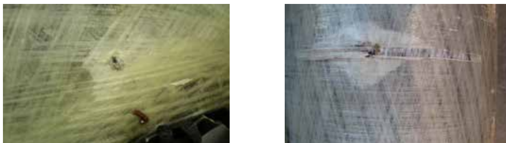
Figura 6: Zone di localizzazione dei danni alle bombole per le bombole di tipo 3A Delaminazione da compressione biancastra in composito di fibra di vetro. In questi due casi le delaminazioni da compressione circondano una scriccatura da impatto.
