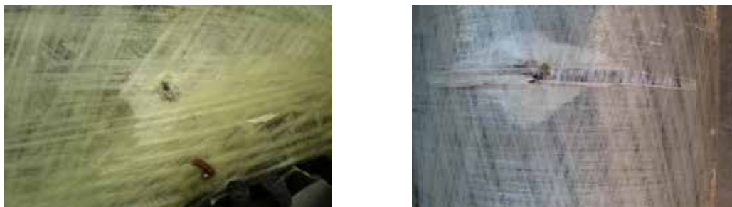
Rysunek 6: Strefy lokalizacji uszkodzeń cylindra – cylindry typu 3A Białe oznaki delaminacji w kompozycie z włókna szklanego. W tych dwóch przypadkach oznaki delaminacji otaczają wgłębienie po uderzeniu.
